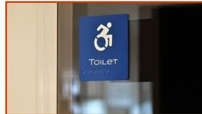
Per segnalazioni di singole informazioni si useranno targhette in Braille o a caratteri a rilievo da collocare ad un'altezza da terra che va da 110 cm a 140 cm
